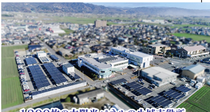
1200枚の太陽光パネルの小城市役所
